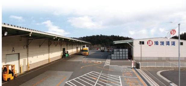
尾道支店尾道流通センター
