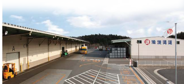
尾道支店尾道流通センター
